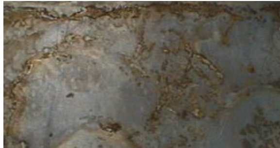
Abb. 1.3.4 Schlechte Spülung, anschließend nass gelagert
