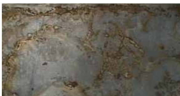
Fig. 1.3.4 Produit stocké mouillé suite à un rinçage insuffisant
