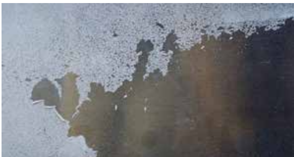
Fig. 3.8.1 Grandes áreas de discontinuidad que no muestran una capa de pintura
