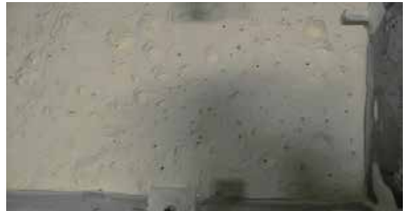
Fig. 2.1.2 Fluidización pobre
