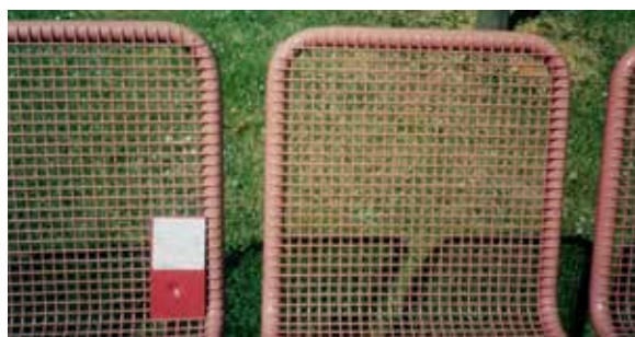
Obr. 5.1.1 Nedostatečná odolnost vůči čistícím prostředkům
