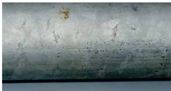
Obr. 3.5.8 Nedokonalé žárové zinkování
